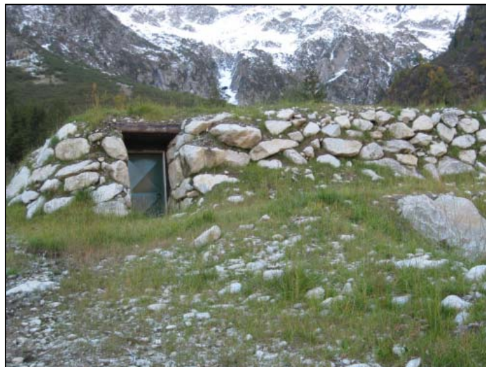
Vasca di carico
