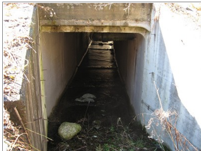
Fotografia 64a-64b-64c – A sinistra risagomatura e sistemazione idraulica del Torrente Ferera con scogliere in massi a valle della la S.S. n. 42, a destra risagomatura (molto stretta) dell'alveo con palificate in legno nel tratto che costeggia il lato orientale del P.L.Sumani e passaggio sotto la S.S. n. 42 prima della confluenza nel Narcanello.
