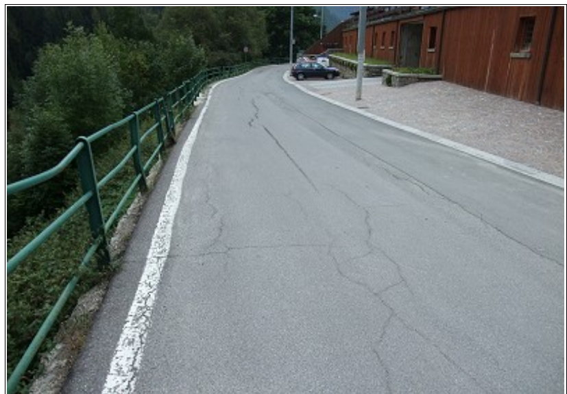
Fotografia 54a -54b– A sinistra cedimenti della banchina stradale per Case di Viso e a destra crepe sulla sede della strada comunale di Precasaglio.
