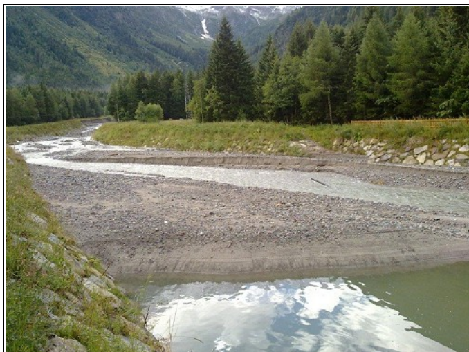
Fotografia 39a -39b – Briglia selettiva e di trattenuta sul Torrente Narcanello all'inizio della Val Sozzine e bacino di sedimentazione a tergo.
