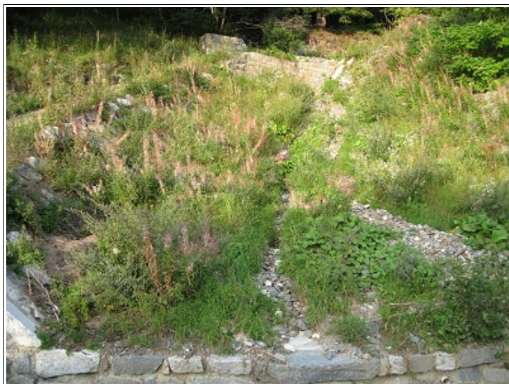
Fotografia 49 – Alveo sovralluvionato lungo il Torrente Rovina immediatamente a monte della S.S. n. 42 del Tonale. Il materiale potrebbe aggirare la briglia e incanalarsi lungo il sentiero esistente in destra idrografica riversandosi sulla statale.
