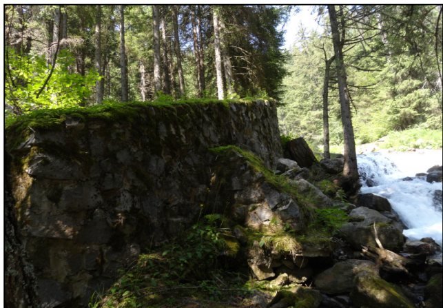
Muro di difesa in sponda destra presente da quota 1440 a 1420 all'apice del conoide del Torrenet Ogliolo per una lunghezza di 100 m, che protegge le antiche aree di deflusso da possibili esondazioni del torrente
