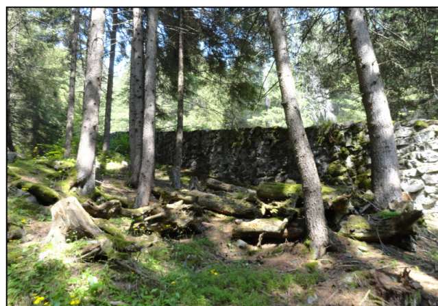
Muro di difesa in sponda destra presente da quota 1440 a 1420 all'apice del conoide del Torrenet Ogliolo per una lunghezza di 100 m, che protegge le antiche aree di deflusso da possibili esondazioni del torrente
