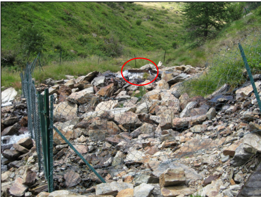
Zona delle sorgenti in adiacenza all'alveo del Torrente Arcanello.
