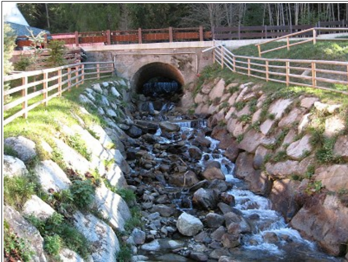
Fotografia 66a -66b – Sistemazione idraulica del Torrente Acquaseria con scogliere in massi e soglie di fondo nel tratto tra la S.S. n. 42 del Tonale e la strada comunale di Valbione.
