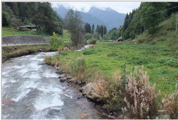
Fotografia 45 – Punto di possibile tracimazione del Torrente Frigidolfo poco a valle dell'ex Molino (oggi Ristorante lungo la S.S. n. 300) sotto Precasaglio, a causa della sponda destra molto bassa e con potenziale allagamento della piana adiacente.
