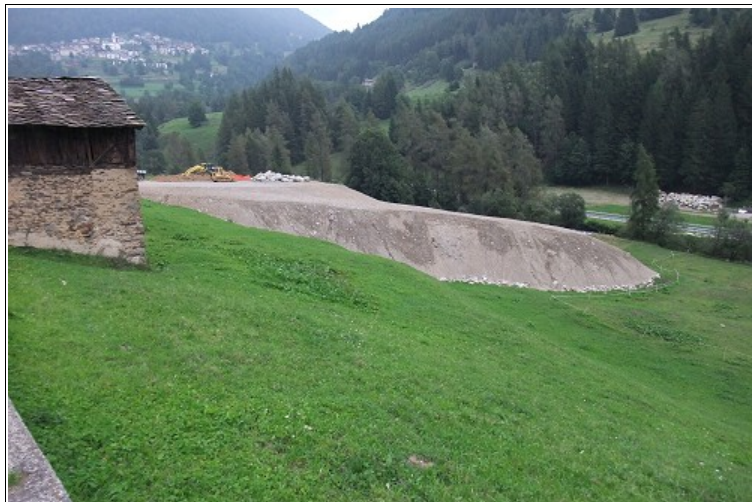
Fotografia 22 – Enorme riporto di materiale derivante da sbancamenti, in sponda sinistra del Torrente Frigidolfo presso il Ponte dei Buoi che ha completamente stravolto la morfologia originaria.
