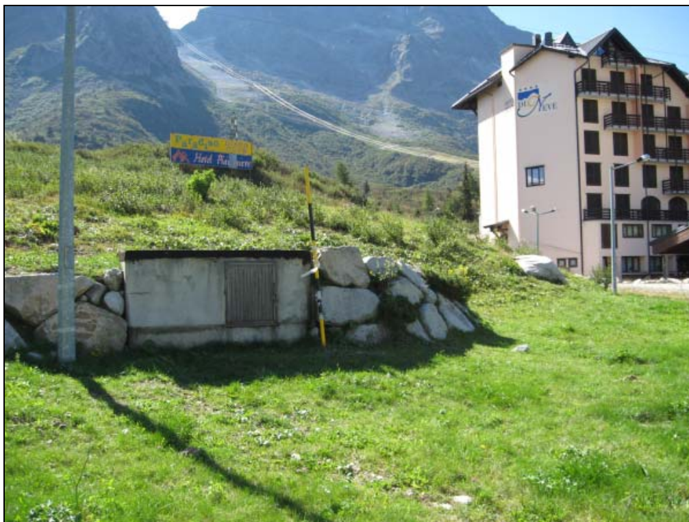
Vista del pozzo del Tonale (ex Società Paradiso).
