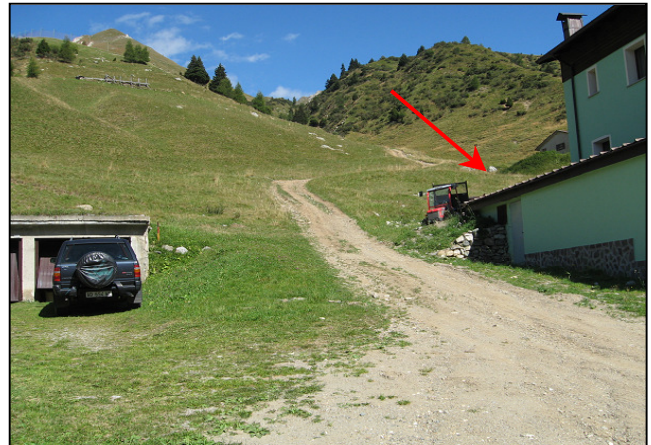
Punto di possibile fuoriuscita della colata in sponda destra a q. 1790 m che scenderebbe fin contro il fabbricato dell'Hotel Alpino (a dx) e lungo la strada fino alla statale.
