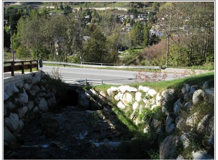
Fotografia 66a -66b – Sistemazione idraulica del Torrente Acquaseria con scogliere in massi e soglie di fondo nel tratto tra la S.S. n. 42 del Tonale e la strada comunale di Valbione.
