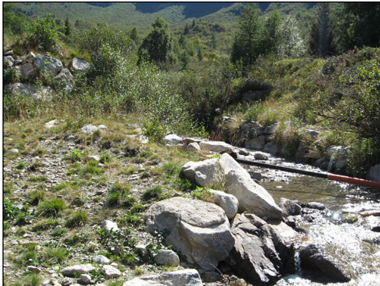
Tubazione di collegamento tra la presa e il serbatoio
