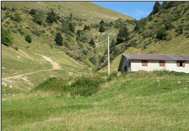
Un ramo della colata passerebbe tra l'alveo e la malga arrivando fino alla statale. Il settore a valle degli edifici resta in ombra e protetto dalla colata ad alta pericolosità
