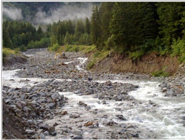
Fotografia 47 – Alveo sovralluvionato lungo il Torrente Narcanello in Val Sozzine, tra la confluenza del Torrente Ogiolo e la briglia di trattenuta.
