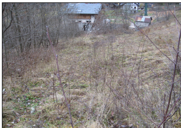
Direzione di propagazione della potenziale colata detritica diretta verso il rudere e la vecchia cascina
