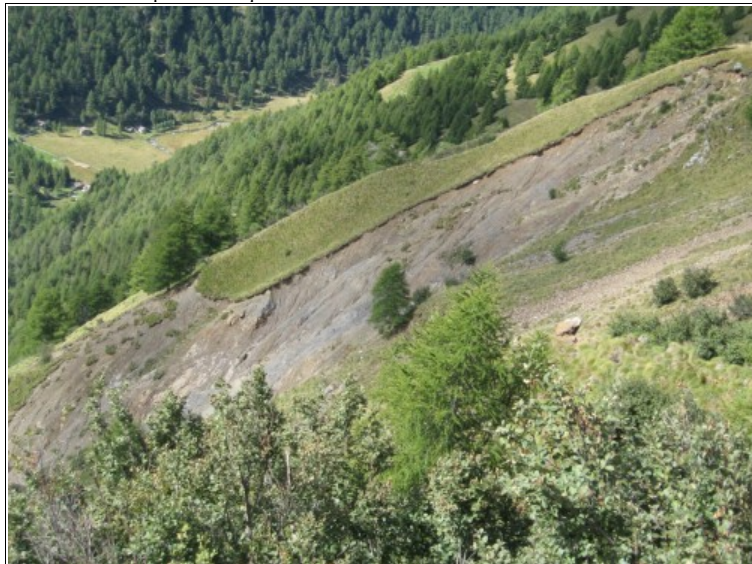
Fotografia 10 – Testata della frana in prossimità dei tornanti della strada S.S. n. 300 del Gavia che alimenta il debris-flow di case degli Orti.
