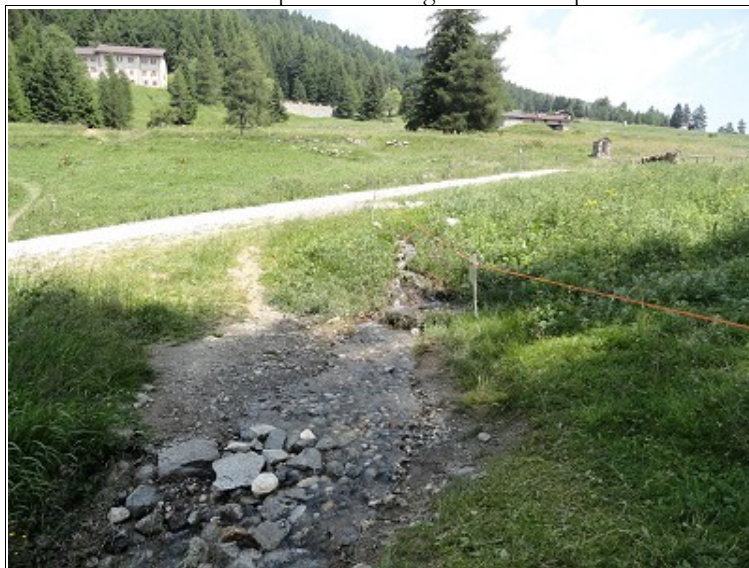
Fotografia 46 – Punto di possibile tracimazione delle acque del torrente dalla valle del Grifone che scende lungo il Tonale, a causa dell'assenza delle sponde.
