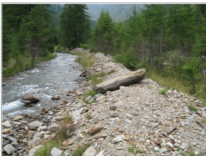
Fotografia 42a -42b – Torrente Frigidolfo che scorre nella piana alluvionale a monte di Case Pradazzo, delimitato in sponda destra da un argine formato da un accumulo di detrito, allo scopo di contenere eventuali esondazioni del corso d'acqua. Nell'immagine di destra la piana potenzialmente allagabile individuata con criteri geomorfologici.
