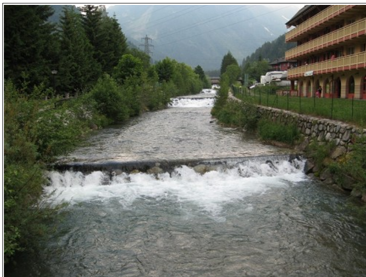
Fotografia 41 – Opere idrauliche di difesa (scogliere spondali in massi e soglie di fondo) lungo il Torrente Narcanello nell'attraversamento dell'abitato di Ponte di Legno.
