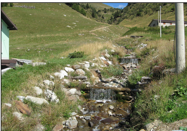
Opere di sistemazione idraulica (scogliere e soglie) realizzate appena a monte dell'attraversamento della S.S. n. 42
