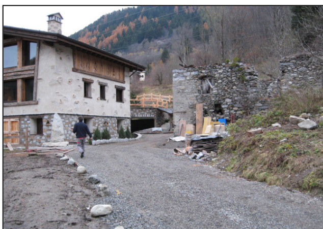
Vista del rudere (a dx) e delle case ristrutturate (a sx). La colata di detrito potenziale proveniente dal settore a monte del rudere si incanalerebbe lungo la strada seguendo la massima pendenza
