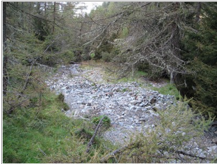
Fotografia 48 – Alveo sovralluvionato lungo il Torrente Acquaseria a monte della piana di Valbione.
