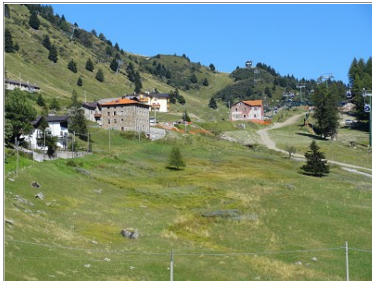
Fotografia 51 – Zone di ristagno delle acque al Tonale sotto la Casa Cantoniera riconoscibili dalla colorazione verde intenso/giallastra dell'erba.
