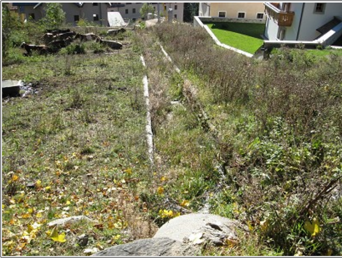
Fotografia 60a -60b – Rio Balza nel tratto a monte di Via Dalegno-Via Marconi. A sinistra è visibile il tratto regimato da privati con sponde in palificate di legno per il passaggio vicino ad alcune abitazioni e a destra il tratto ancora più a monte caratterizzato dall'assenza di un alveo e dalla presenza di numerose venute d'acqua e ristagni.
