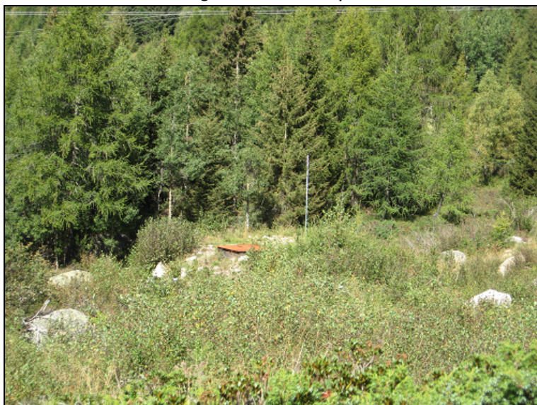
Serbatoio seminterrato con i tombini visibili sulla sommità
