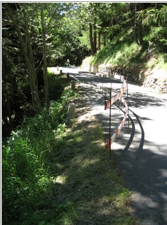
Fotografia 54a -54b– A sinistra cedimenti della banchina stradale per Case di Viso e a destra crepe sulla sede della strada comunale di Precasaglio.
