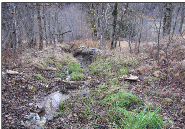
Canale attivo del Torrente Rovina a valle della Strada Statale n. 42 del Tonale con alveo poco definito e punti di possibile tracimazione
