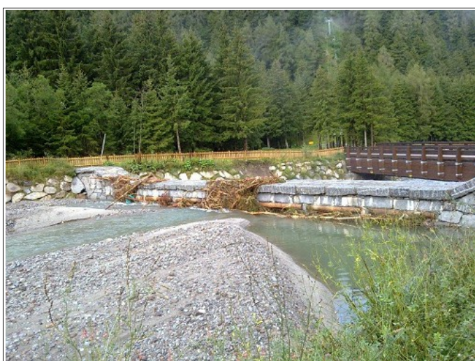
Fotografia 40a -40b – Evento alluvionale avvenuto a fine agosto 2010 che ha “collaudato” la briglia. L'opera ha trattenuto il materiale alluvionale e i detriti evitando che arrivassero fino all'abitato di Ponte di Legno. Gli unici danni furono l'erosione delle sponde del Torrente Narcanello a monte della briglia (zona Val Sozzine-Albergo Tana dell'Orso) con rottura dell'acquedotto che passa nel rilevato in sponda destra del corso d'acqua.
