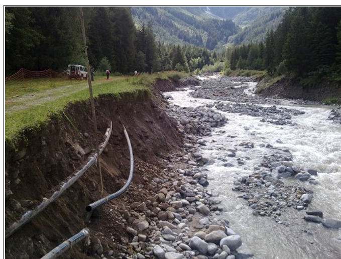
Fotografia 40a -40b – Evento alluvionale avvenuto a fine agosto 2010 che ha “collaudato” la briglia. L'opera ha trattenuto il materiale alluvionale e i detriti evitando che arrivassero fino all'abitato di Ponte di Legno. Gli unici danni furono l'erosione delle sponde del Torrente Narcanello a monte della briglia (zona Val Sozzine-Albergo Tana dell'Orso) con rottura dell'acquedotto che passa nel rilevato in sponda destra del corso d'acqua.
