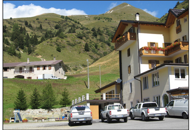
La colata detritica arriverebbe diretta alla malga (a sx) e all'Hotel Bezzi (a dx) e verrebbe divisa in rami dai fabbricati che costituiscono un ostacolo al flusso
