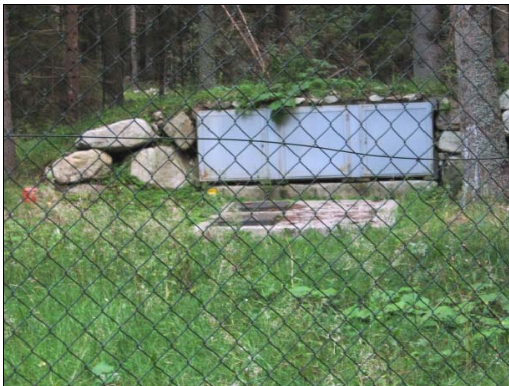
Tombini a filo piano campagna della camera del pozzo all'interno della recinzione della Zona di Tutela Assoluta, nella pineta in Val Sozzine.
