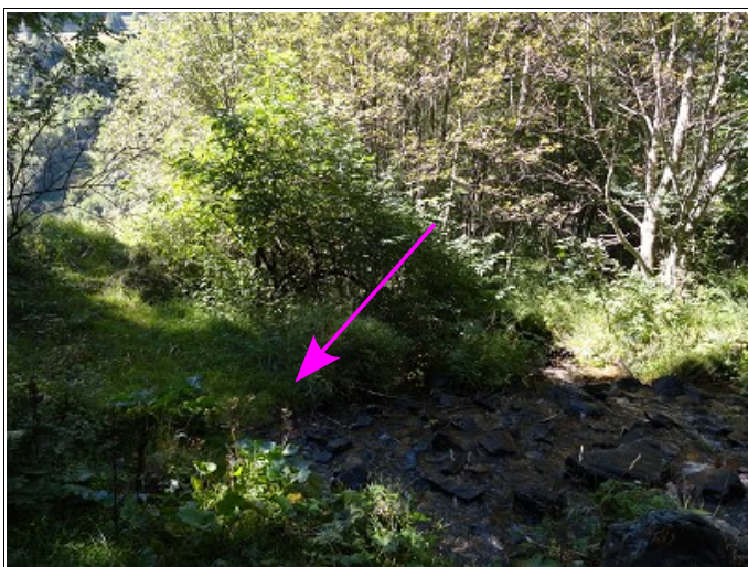
Fotografia 73a -73b – Punto critico per assenza delle sponde e alveo a raso a q. 1360-1365 del torrente Valle di Calò. L'acqua e la colata detritica potrebbero uscire in sinistra idrografica e scendere seguendo la massima pendenza lungo i prati e la stradina esistente.
