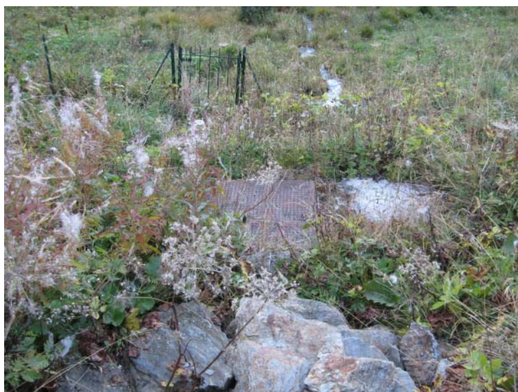
Sorgenti lungo il pendio in Valle di Viso, con dettaglio di un tombino di presa
